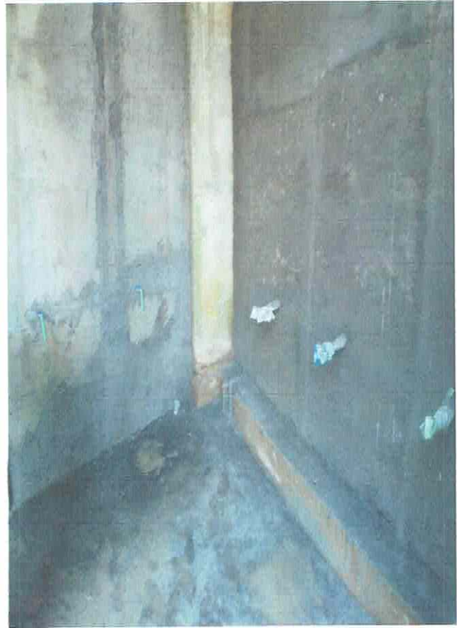
Dinding Tempat Wudhu setelah di Plester
