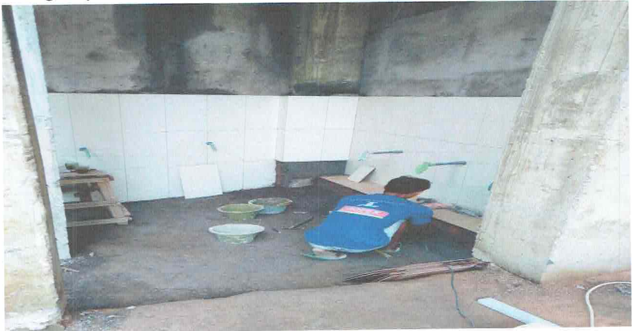
Pemasangan Keramik Dinding dan Lantai Tempat Wudhu
